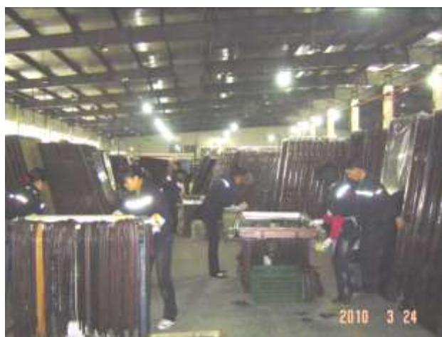
写真1 住宅用門扉組立状況
